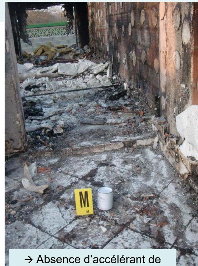
→ Absence d'accélération de combustion sur le scellé M
